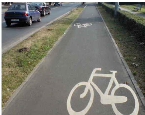
Rys. 10. Przykład drogi dla rowerów odseparowanej od ruchu samochodów oraz pieszych [13]
